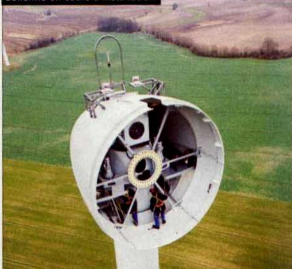
Eolienne en cours d'installation
