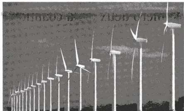
Vue partielle des 25 éoliennes de la « ferme » de Port-Saint-Louis-du-Rhône (Bouches-du-Rhône). GÉRARD JULIEN/AFP
