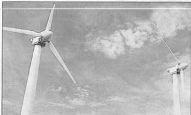
La société Eole est en charge de la construction du parc éolien de Saint-Pierre-sur-Dives.
